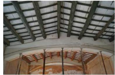
Figura 38. Can Gaietano. Cobertura de vigamento de madeira sobre arcos torais.
