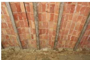
Figura 50. Can Viguetà. Abobadilha cerâmica.
