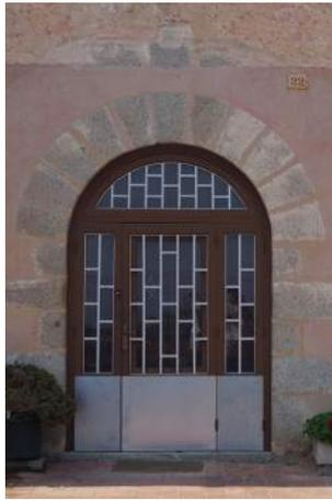
Figura 88. Can Lladò. Portal com aduelas em arco de volta inteira.
