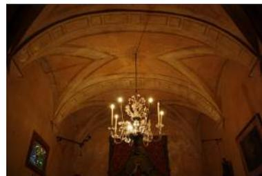
Figura 49. Can Calderó. Abóbada de berço com penetrações.
