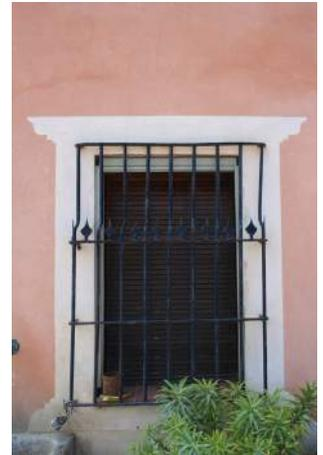
Figura 71. Can Oriach. Janela com moldura esgrafitada do tipo classicizante
