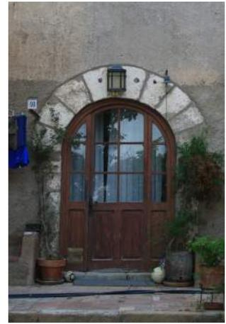
Figura 89. Can Vilà. Portal com aduelas em arco de volta inteira.
