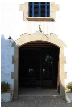
Figura 90. Can Cirera. Portal com arco rebaixado.
