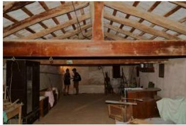
Figura 37. Can Mora. Cobertura de estrutura de asnas de madeira.
