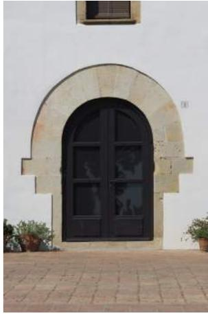
Figura 85. Can Andreu. Portal com aduelas em arco de volta inteira.
