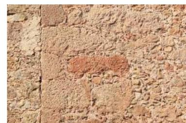
Figura 30. Els Callís. Paramento em alvenaria de pedra.
