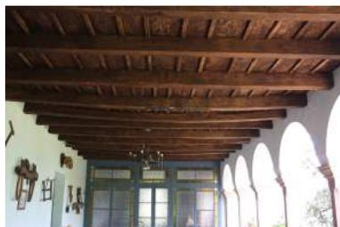
Figura 31. La Plana. Cobertura do corpo das galerias com vigamento de madeira.
