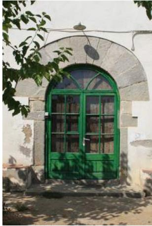
Figura 84. Can Fabrègues. Portal com aduelas em arco de volta inteira.
