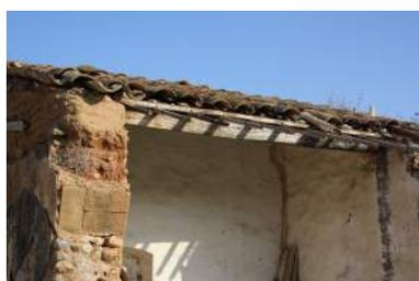
Figura 25. Can Gaietano. Paramento em alvenaria e taipa.
