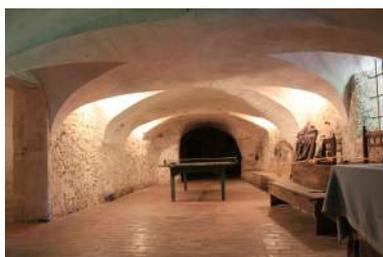
Figura 52. El Ventòs. Abóbada de berço com penetrações.
